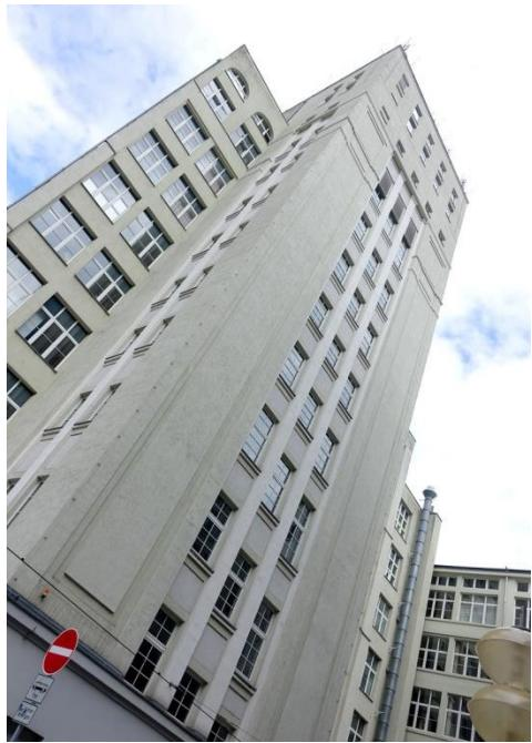
Mit den fünf Nutzgeschossen wird die Feuerwehrgrenze von 22 Metern noch eingehalten. Die Gesamthöhe von 40 Metern erreicht der Turm durch ein hohes, in Holzbauweise ausgeführtes gestaffeltes Steildach und einen aufgesetzten, mit Jugendstilelementen dekorierten, weithin sichtbaren Uhrturm. Das 1905 fertiggestellte Gebäude hatte zwar mit 40 Metern eine damals beeindruckende Höhe, aber als Hochhaus galt der Bau mit sechs Geschossen noch nicht.
